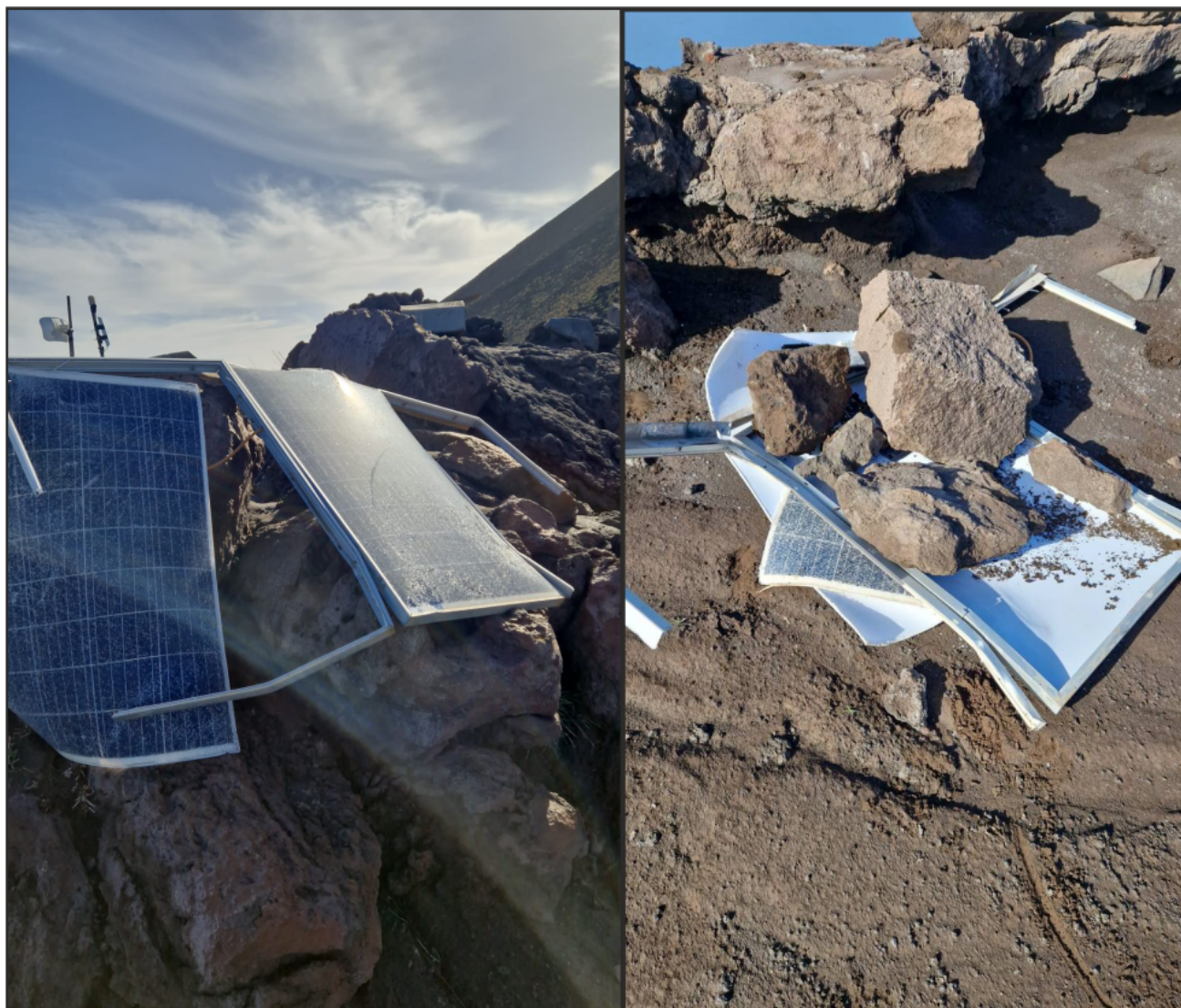
Figura 5 – Danni rilevati alla stazione ROC durante il sopralluogo in data 3 Febbraio 2026.
